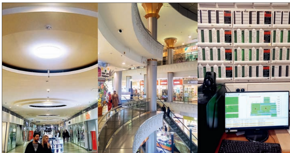
Рис. 2. "Стрелец-ПРО" позволил провести переоснащение без остановки работы ТРК "Сенная"
